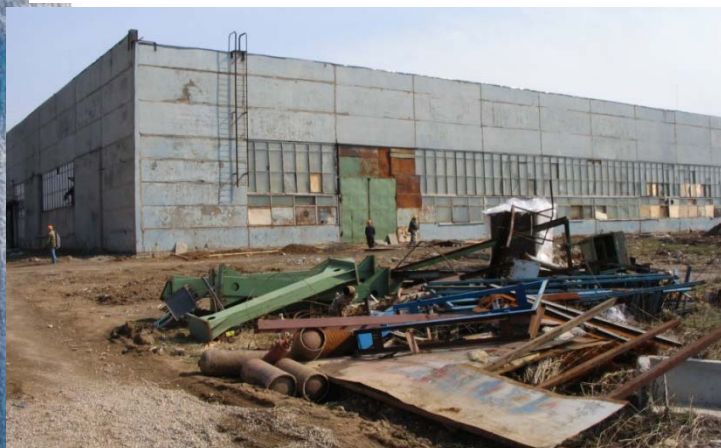
начало производства работ
